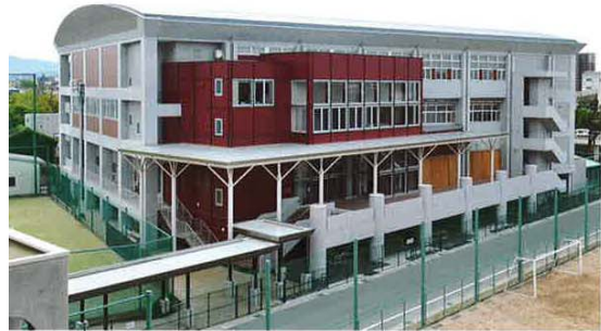
総合体育館 2010年に竣工したばかりの真新しい体育館。メイン、サブの2つのアリーナをはじめトレーニングルームや卓球場を備えています。
